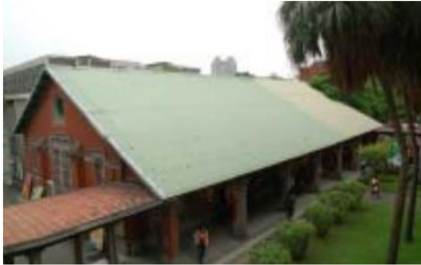
圖 06.火災後文薈廳以鐵皮屋頂改建
